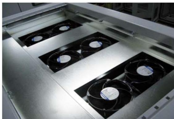
Foto 43: Ventilatori del modulo elettronico di potenza (XP350-HV TL)
