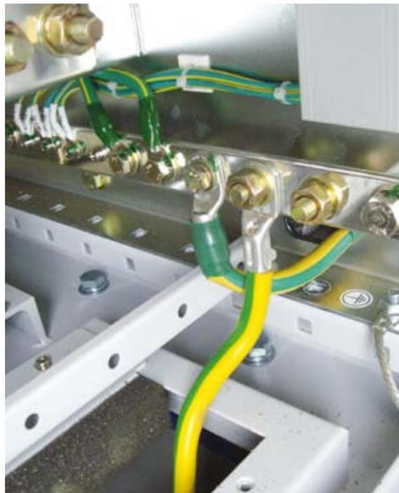
Foto 7: Barra di messa a terra di protezione
